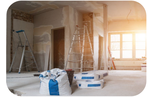
Commercial tenant build out
